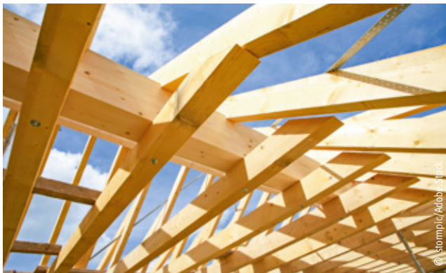
Bauen mit Holz schützt das Klima.
